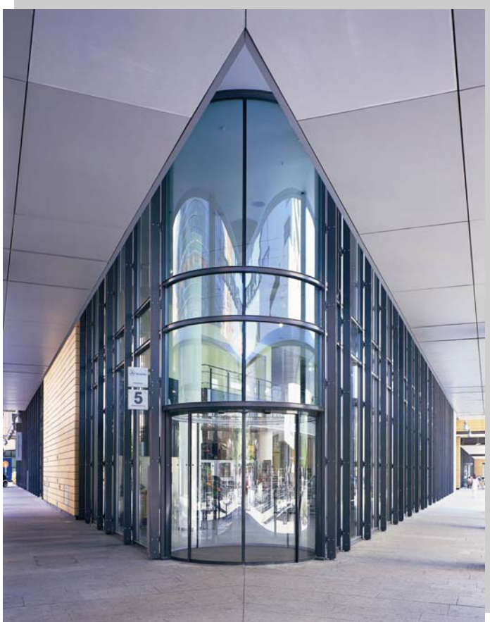
Unterflur-Rund-Schiebetür 2x2 flügelig Debis Systemhaus, Berlin – perfekte Archidektur
