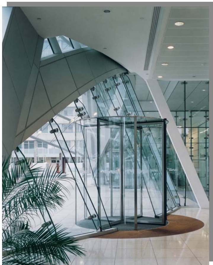
Unterflur- Karusselltür 4-flügelig City Point London – modern und transparent
